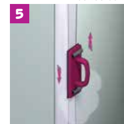
5 Se aplică un strat subțire de ipsos de îmbinări pe partea de deasupra benzii și așteptați până se usucă complet, șlefuiți suprafața uscată utilizând șmirghel cu granulație de min. 200
