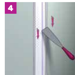
4 Pentru a îndepărta surplusul de compus și bulele de aer, se folosește un șpaclu
