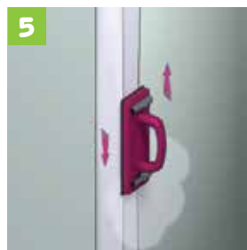
5 Se aplică un strat subțire de ipsos de îmbinări pe partea de deasupra a benzii și așteptați până se usucă complet, șlefuiți suprafața uscată utilizând șmirghel cu granulație de min. 200
