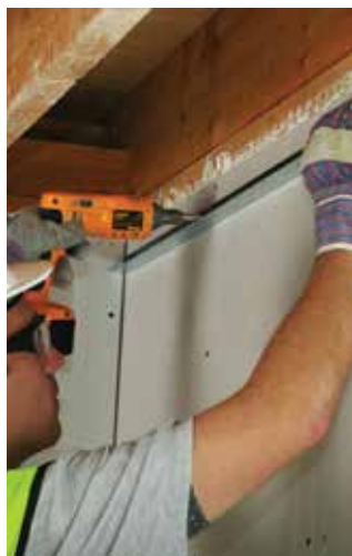
Trasarea și fixarea profilelor perimetrare UD
